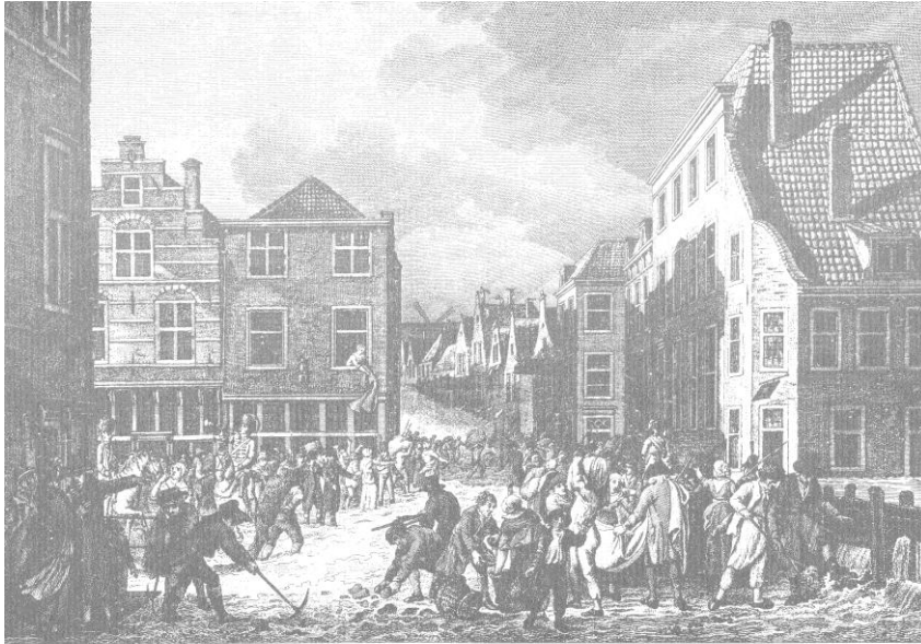
Het beswyken der bekisting op den Kortendijk te Gorinchem - in Louwmaand 1809.
